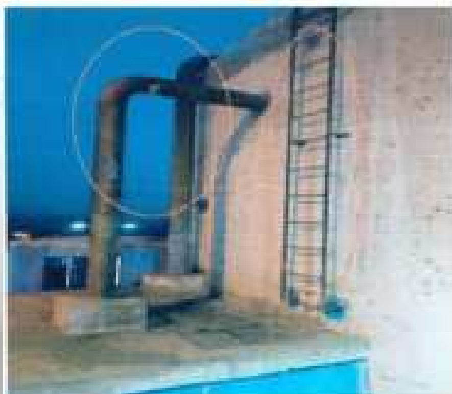
Reservorio Buena Vista 1500 m 3
